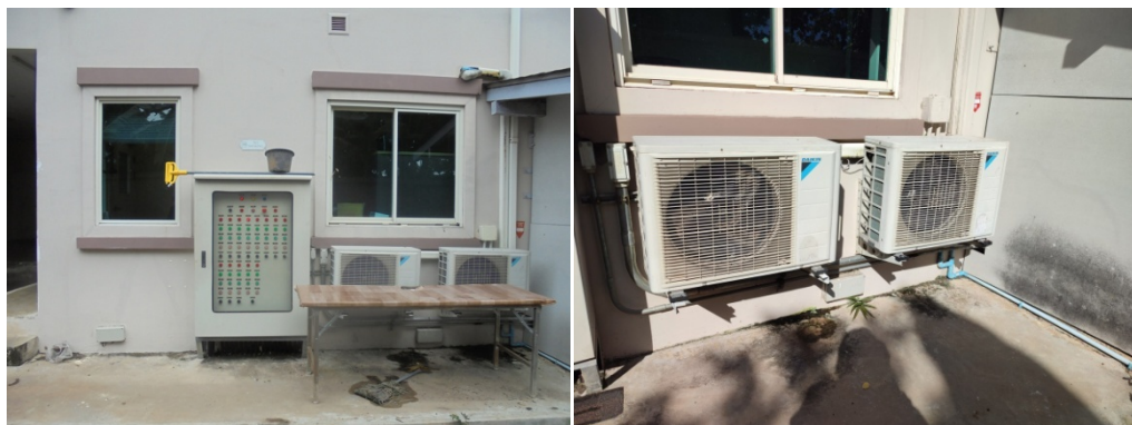
ภาพที่ 3-35 เครื่องปรับอากาศ แบบ Split Type ประหยัดพลังงาน
