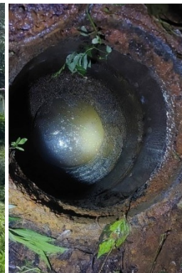
ภาพที่ 3-10 สูดตะกอนไขมันออกจากถังแยกตะกอน
