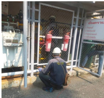
ภาพที่ 3-39 ถังเคมีดับเพลิง ติดตั้งไว้บริเวณที่เก็บถังแก๊ส และตรวจสอบให้มีความปลอดภัย
