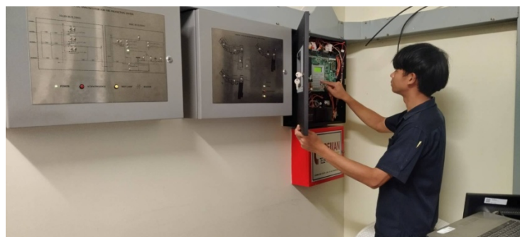
ภาพที่ 3-26 ตรวจสอบระบบป้องกันและเตือนอัคคีภัย พร้อมใช้งาน
