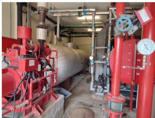
ภาพที่ 3-25 ห้องเครื่องสูบน้ำดับเพลิง ตรวจสอบไว้แล้วและเปลี่ยนอุปกรณ์ปัจจุบันอยู่ในสภาพดีพร้อมใช้งาน
