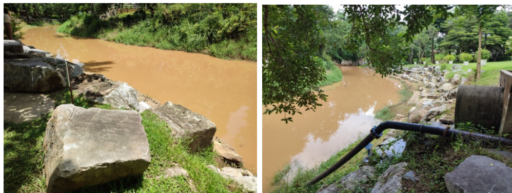
ภาพที่ 3-2 กำแพงดินเป็นภูเขารธรรมชาติ ใช้หินอ่อนตัดก้อน ทำเป็นกำแพงดินมีความลาดเอียงไม่เกิน 45 องศา และบ่อกักน้ำก่อนระบายออก
