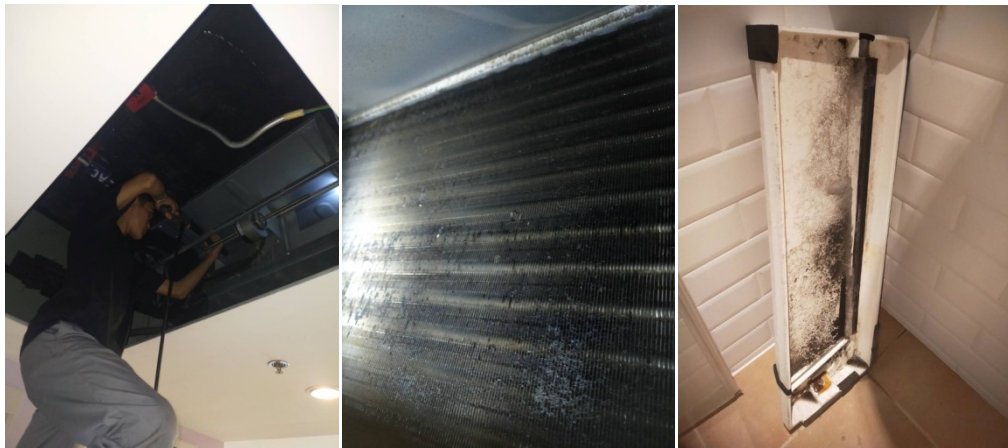
ภาพที่ 3-41 ล้างทำความสะอาดเครื่องปรับอากาศ
