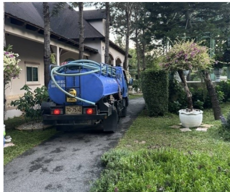
ภาพที่ 3-10 สูดตะกอนไขมันออกจากถังแยกตะกอน
